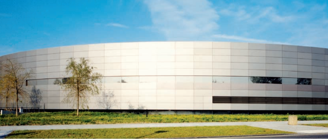
Blick auf die Außenfassade der Synchrotronstrahlungsquelle BESSY II in Adlershof.
