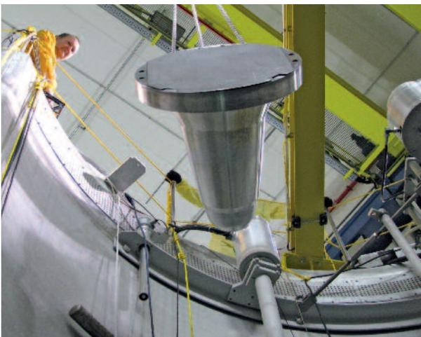
Das Konische Strahlrohr wird in Position gebracht.
