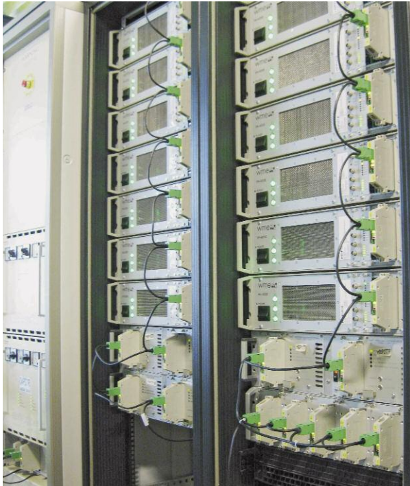
Im Rahmen des Upgrade an BESSY II wurde auch diese Anlage für die hochstabile Magnetstromversorgung des BESSY-II-Speicherrings aufgebaut.
