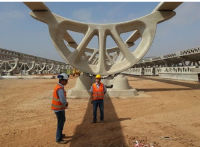
Diese gigantischen Zementstrukturen werden aktuell im Süden Marokkos aufgebaut, wo ein großes solarthermisches Kraftwerk geplant ist (CSP Ait Baha). Sie sollen verspiegelte Rinnen tragen, die die Sonnenhitze konzentrieren. Eine Leitung im Brennpunkt dieser Rinnen enthält eine Flüssigkeit, die stark erhitzt wird. In weiteren Schritten kann über eine Dampfturbine Strom erzeugt werden. Ein marokkanisches Zementwerk stellt die Trägerstrukturen her.
